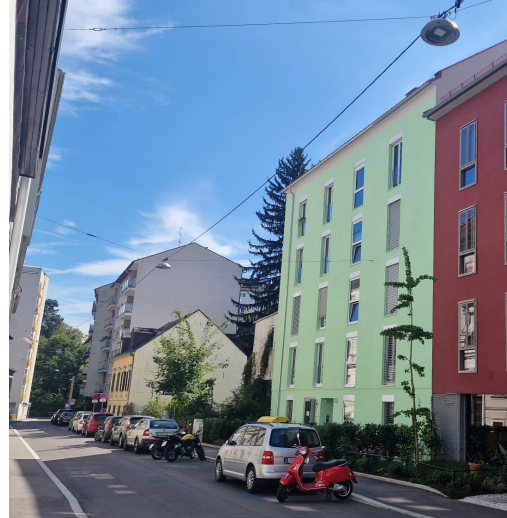
Baulücke in verkehrsberuhigter Einbahnstraße.
