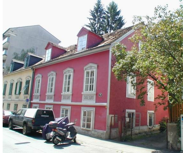
Bestandsfoto von 2002. Das ursprüngliche Gebäude.
