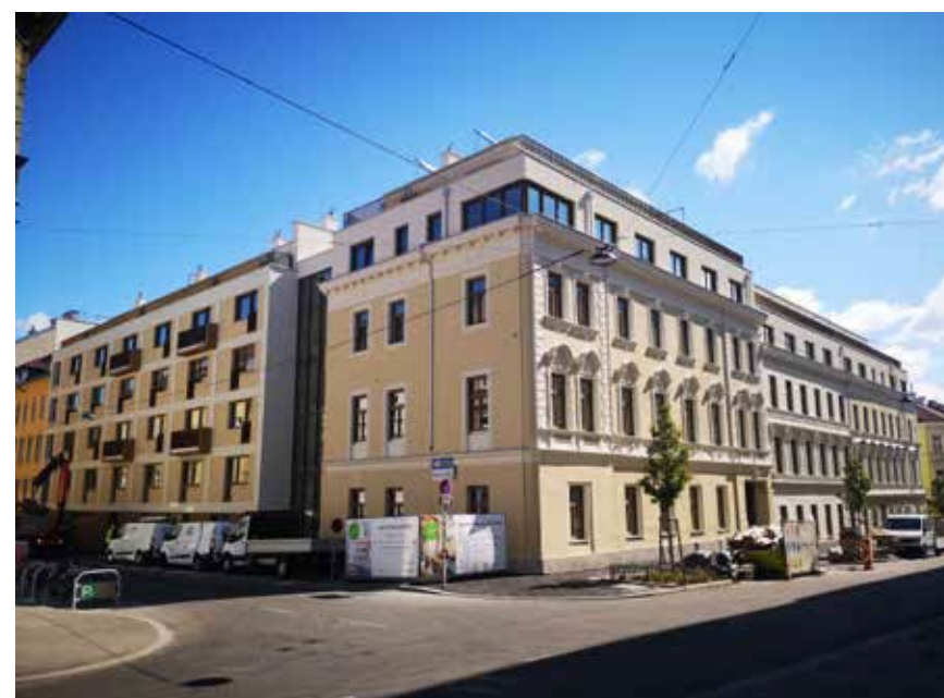
Manner Häuser Geblergasse 116-120, Kulmgasse 18-20, 1160 Wien
