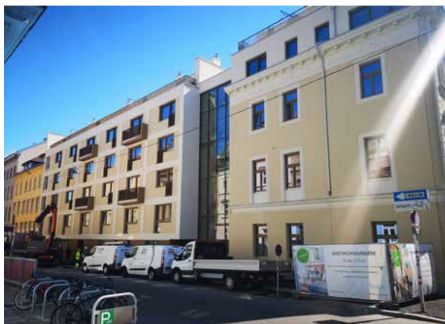
Manner Häuser Geblergasse 116-120, Kulmgasse 18-20, 1160 Wien
